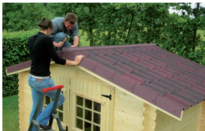
ONDUVILLA® : un système complet, particulièrement rapide à mettre en œuvre et au prix public très attractif. Ici, la mise en place de la faîtière
